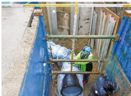
新しい施設や地域に上下水道を布設したり、老朽化した設備の交換工事を行います。国道の水道管など大型の施工から、戸建て・マンション・ビル・商業施設など、現場の規模を問わずさまざまな建物を対象とする施工を請け負っており、地域のライフラインを支える重要な仕事です。
